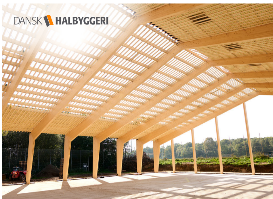
Et særligt element i det nye tenniscenter i Helsingør er valget af en trækonstruktion frem for den traditionelle stålkonstruktion.
